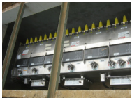
Equipo de seccionamiento y protección para redes en media tensión.
